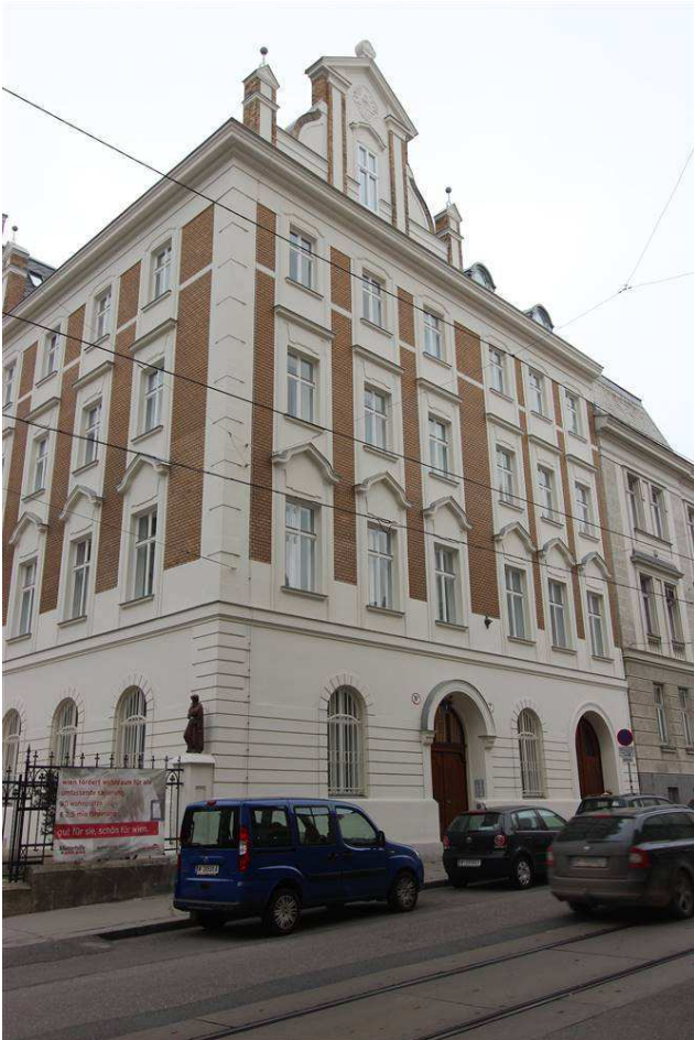
Klostergebäude Kaiserstrasse (box-type window) after renovation, © Courtesy of Trimmel Wall Architekten ZT GmbH
